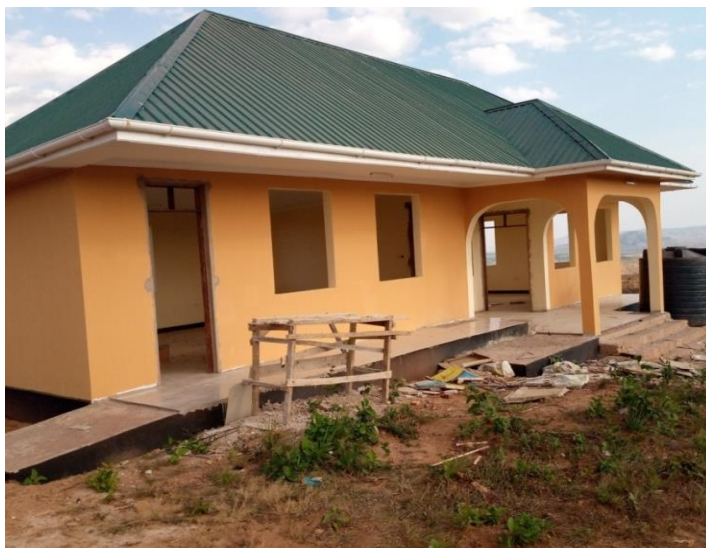
Ujenzi wa kituo cha Vijana Halmashauri ya wilaya ya Buhigwe.
